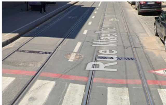
Figuur 254: Afvoerkolken in het midden van de tramsporen Waelhemstraat (Google Street View, 2020)
