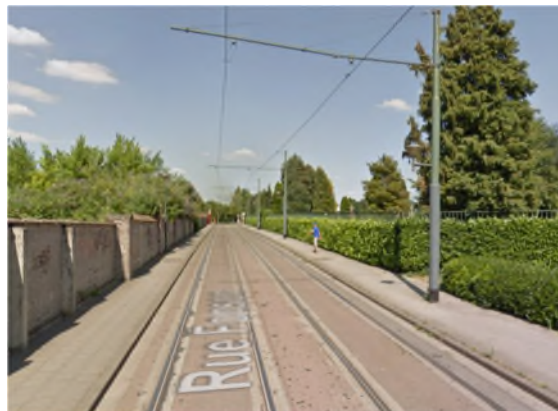
Figuur 257: Bestaande eigen trambedding Fonsonstraat (Google Street View, 2013)
