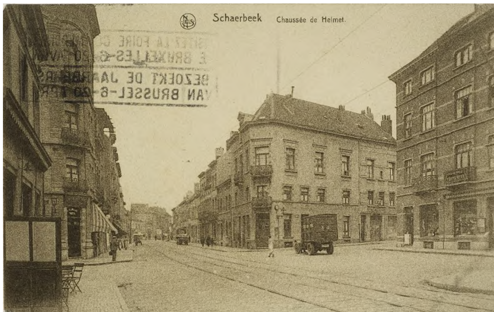
Figuur 154: Foto's van de Helmetsesteenweg ter hoogte van de Heilige Familiekerk (boven) en de Raafstraat (beneden) daterend van vóór 1920 volgens BruCiel (Bron: Postkaarten Belfius)
