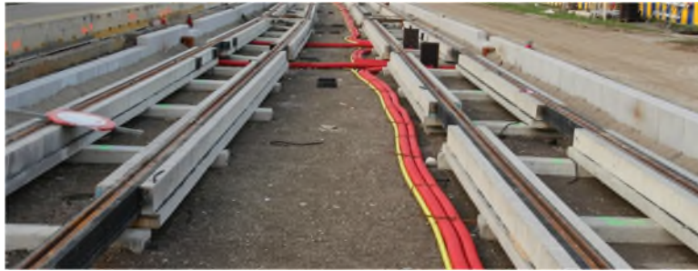
Figuur 245: Installatie van spoorbalken (D2S, 2018)
