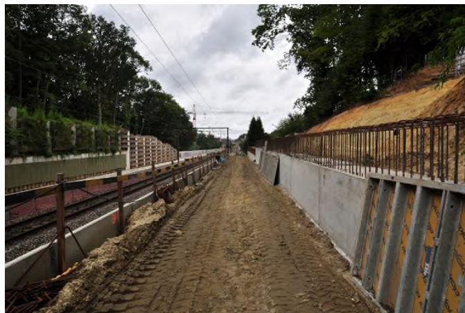
Figuur 173: Voorbeeld van de installatie van keermuur in Rixensart om de aanleg van RER-sporen mogelijk te maken (Rail-be.net)
