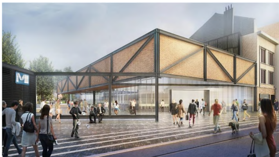
Figuur 107: Station Vrede, zicht op het toegangspaviljoen (BMN, 2018)
