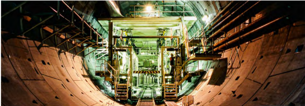
Figuur 20: Illustratie van de achterzijde van een tunnelboormachine met een diameter van 10m, metro van Sydney (bron bouygues-construction.com)
