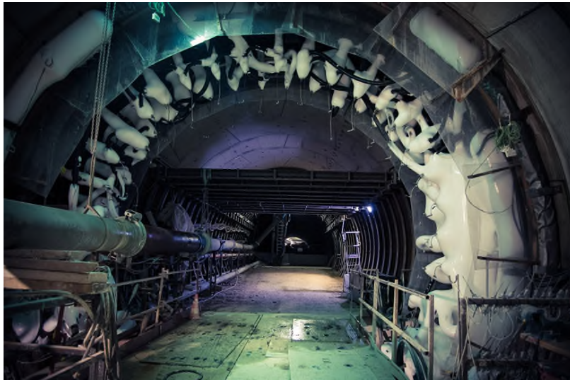
Figuur 34: Bevriazing in een micro-tunnelboormachine (congelationmetro-12.fr)
