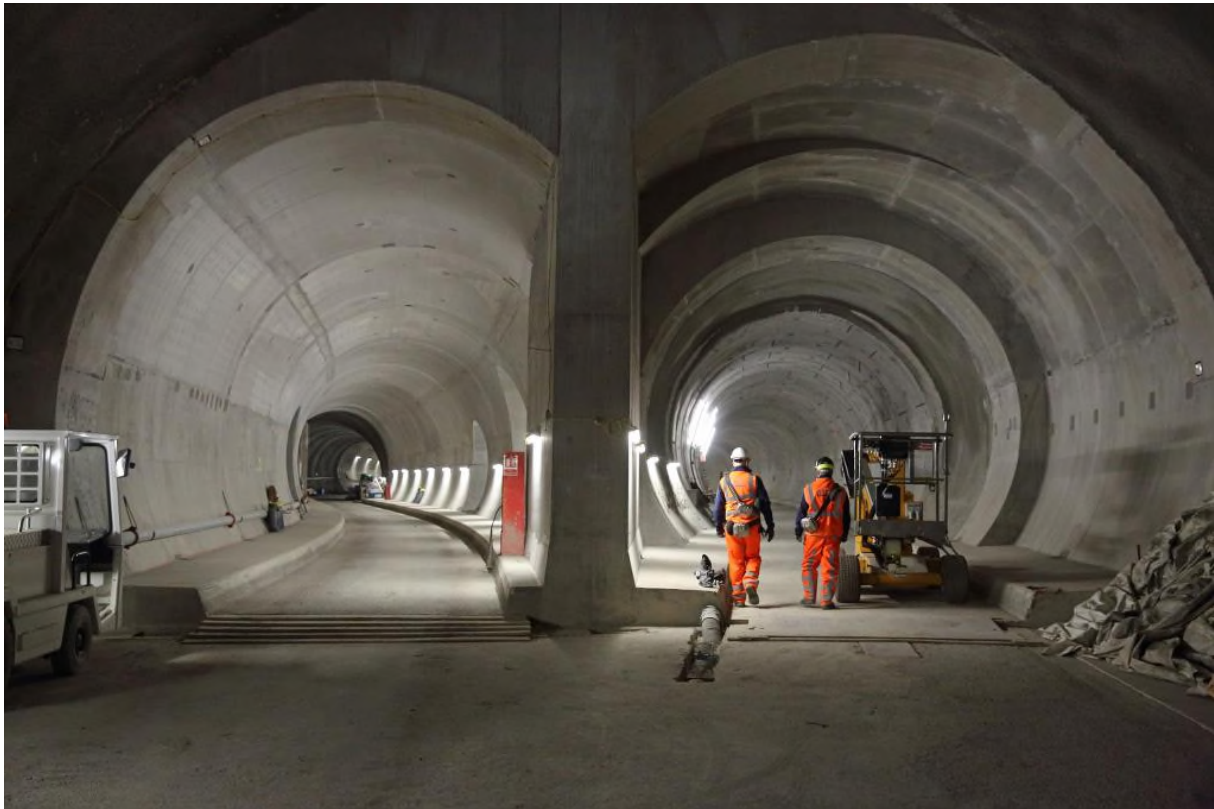
Figuur 88: Bouw van de nieuwe metrolijn in Londen met een dubbele buis, foto van een aftakkingskunstwerk voor een station (Bron: vinci-construction-projets.com)
