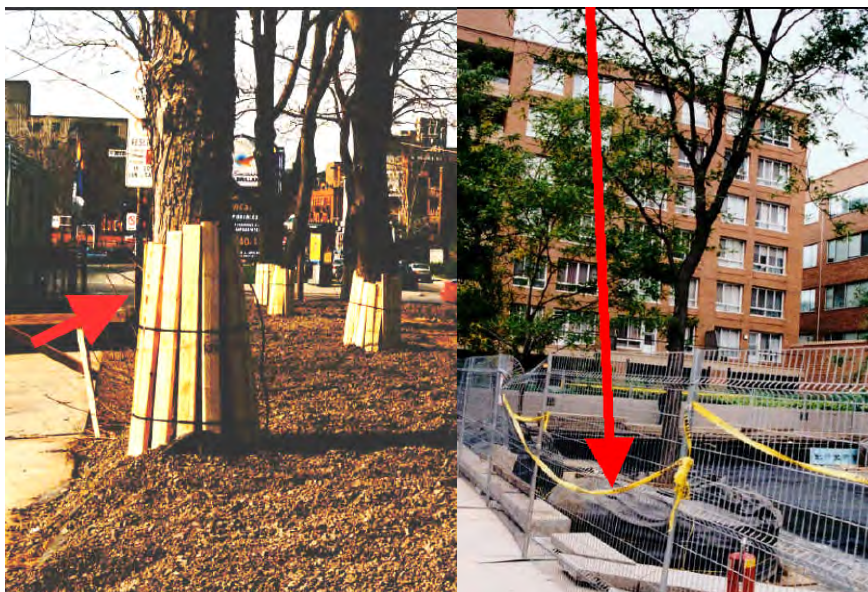
Figuur 239: Voorbeeld van de bescherming van bomen en wortelstelsels tijdens de werf (bron: http://www.metiersdupaysage.com )
