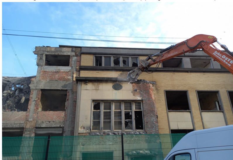
Afbraak van het gebouw Infrabel in 2020 (Metro3.be, 2020)
