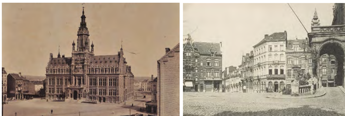
Figure 72 : L'hôtel communal de Schaerbeek vers 1900 (à gauche) (Maison des Arts de Scharbeek/fonds local) et la place Colignon (à droite) (Collection Dexia Banque ARB RBC) (Irismonument, 2020)
