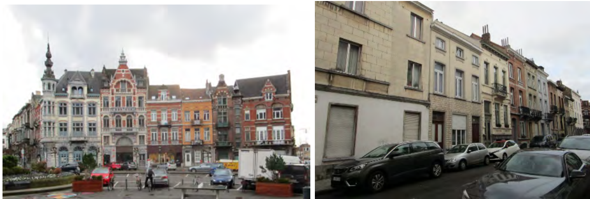
Figure 78 : Façades donnant sur la place (gauche) et façades d'une rue derrière la place (droite) (ARIES, 2020)
