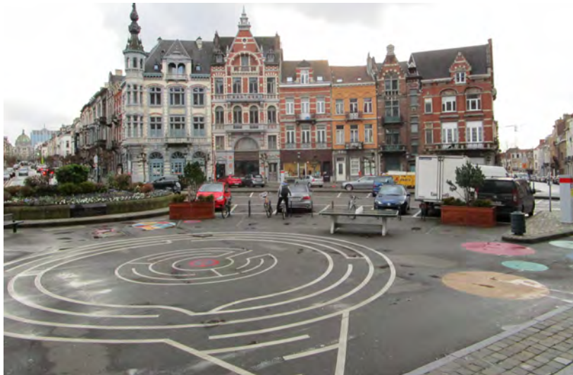
Figure 27 : Aménagement pour piétons sur la place Colignon (ARIES, 2020)
