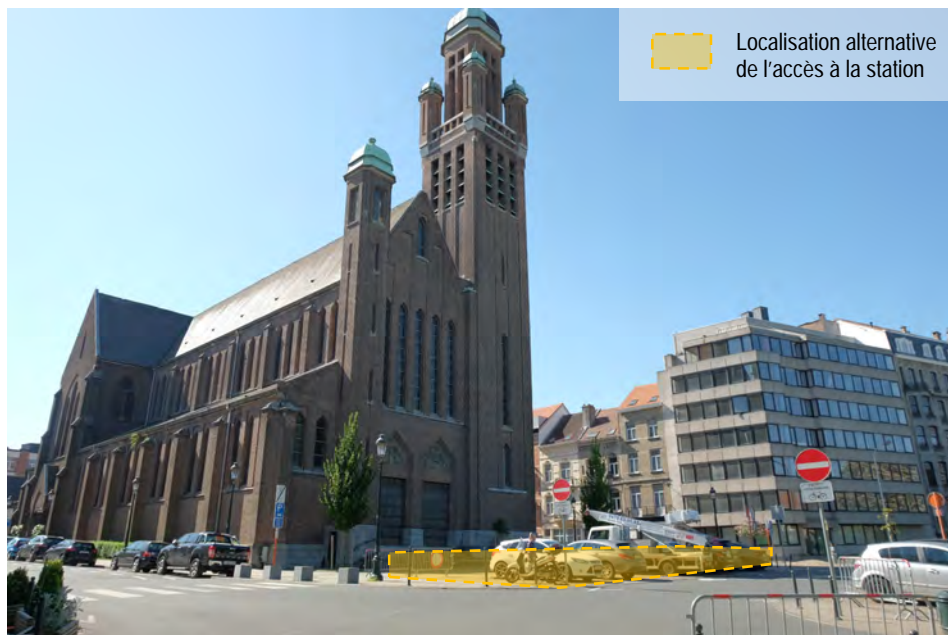
Figure 130 : Vue de l'église depuis le nord (ARIES, 2020)
