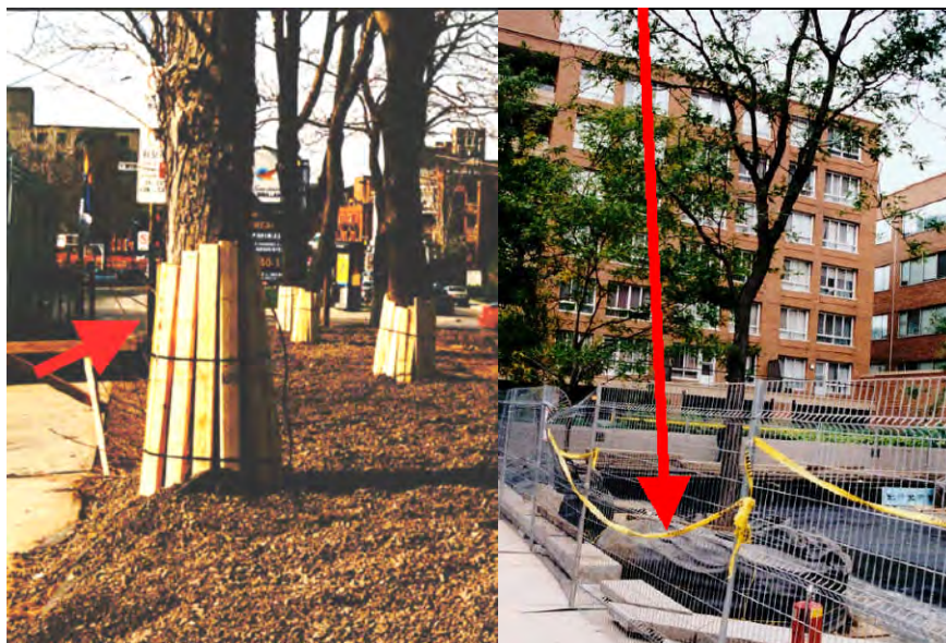
Figure 231 : Exemple de protection des arbres et systèmes racinaire lors de chantier (source : http://www.metiersdupaysage.com )
