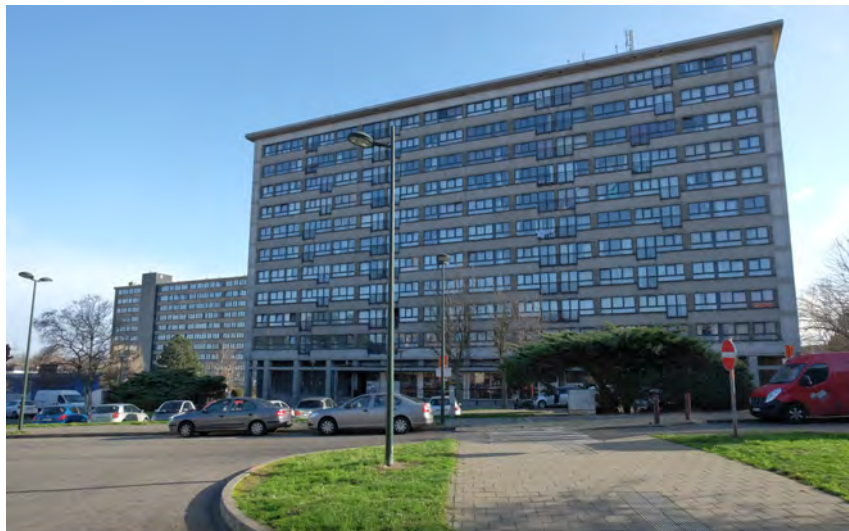
Figure 57 : Barres de logement à l'est de la rue Frans Verdonck (ARIES, 2020)
