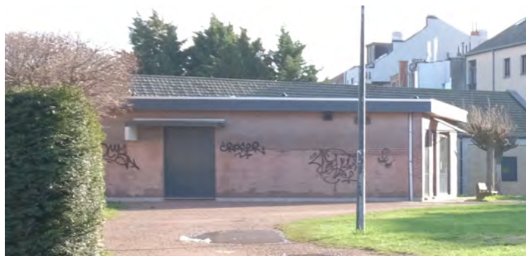
Figure 62 : Vue A : construction dans le parc au sud de la rue Henri Van Hamme (ARIES, 2020)
