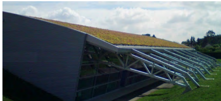
Figure 278 : Exemple de toiture verte sur structure légère : Gymnase de St Genis Laval - Le Prieuré Vegetal i.D. ( http://www.vegetalid.fr )
