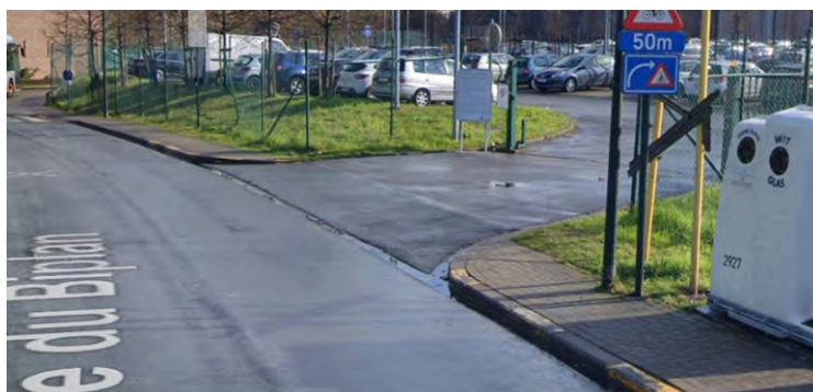
Figure 109 : Absence d'aménagement de la traversée de l'accès vers le parking P18 de la STIB (Google Street View, 2019)
