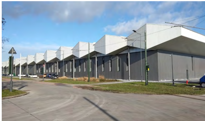
Figure 63 : Bâtiment du dépôt existant de la STIB (ARIES, 2020)
