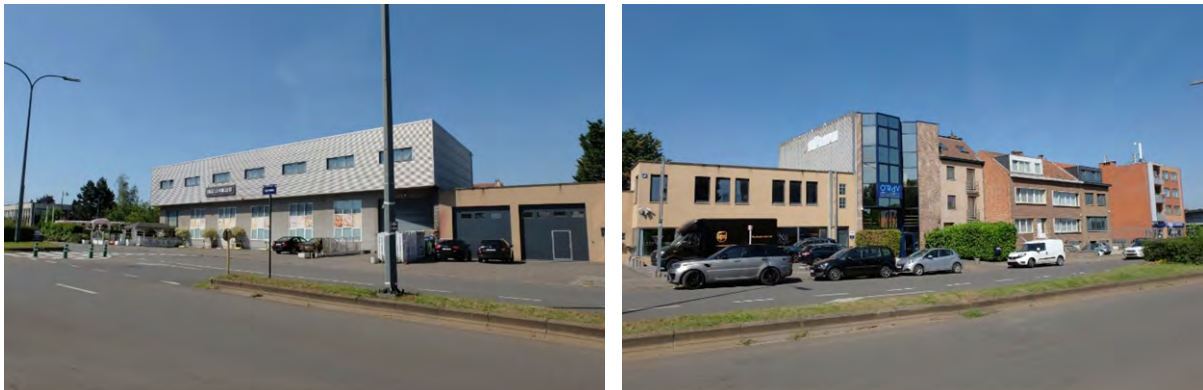
Figure 60 : Vue des constructions existants sur la voirie Houtweg (ARIES, 2020)
