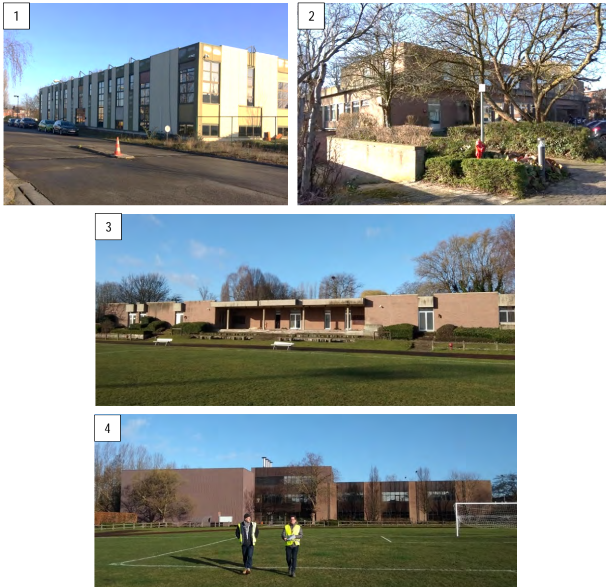
Figure 42 : Bâtiments à démolir sur le site du dépôt (ARIES, 2020)
