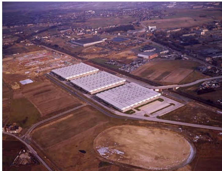
Figure 57 : Vue aérienne des dépôts de bus ainsi que le chantier du terrain d'athlétisme dans les années 1970 (STIB/MIVB ; extraite de BruCiel, 2020)
