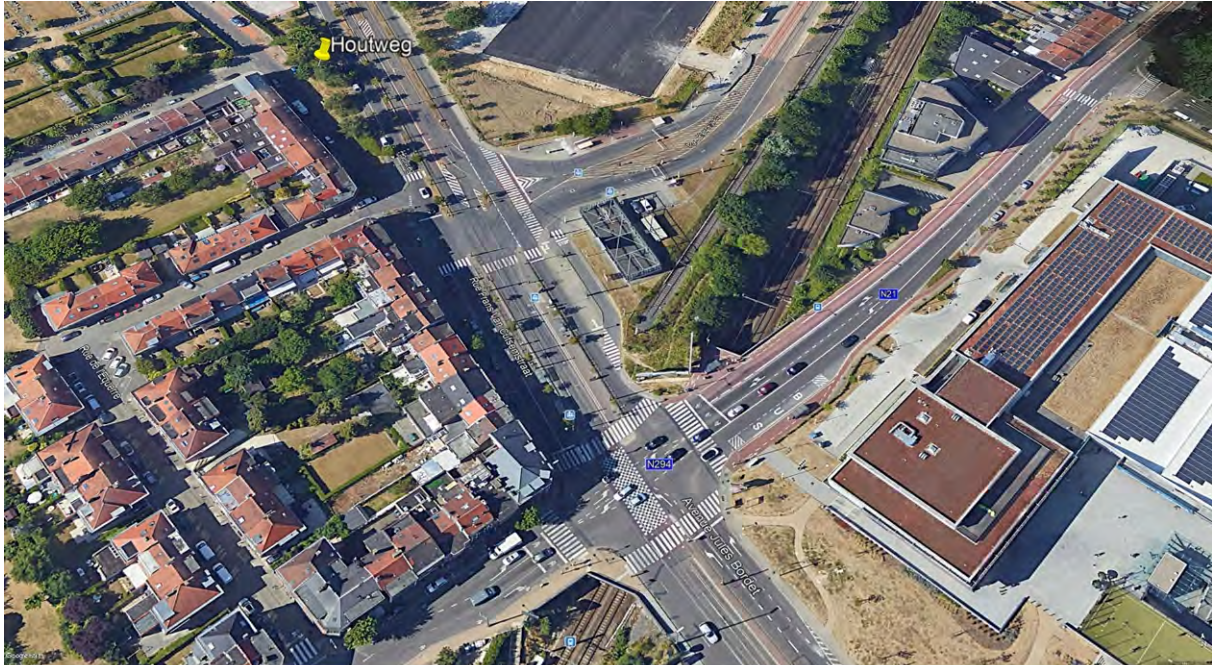
Figure 170 : Emplacement de l'appareil de mesure au niveau du n°10 (Google Earth Pro)
