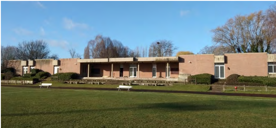
Figure 71 : Vue de la façade est des vestiaires (ARIES, 2020)
