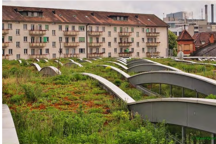
Figure 280 : Toit végétalisé du dépôt de Tram de la ville de Bâle (construction légère avec une couche drainante en paille de miscanthus de 10cm) ( http://naturetoit.blogspot.com/2014/07/le-wiesenteppich-de-bale.html )
