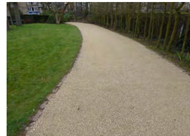
Cheminement en dolomie (Pussemier, 2020)
