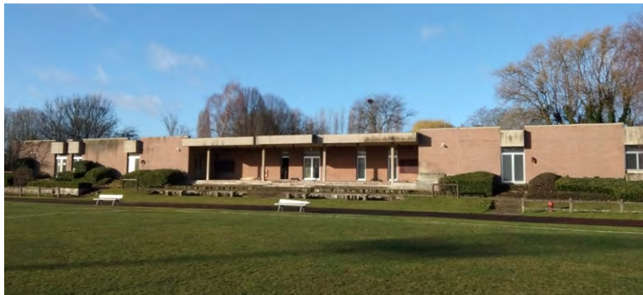
Figure 9 : Bâtiment de vestiaires (ARIES, 2020)
