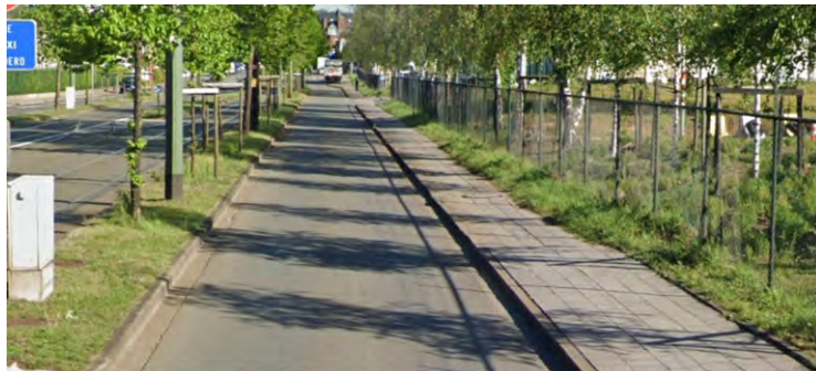
Figure 107 : Vue sur le trottoir de Houtweg - côté "STIB" (Google Street View, 2019)
