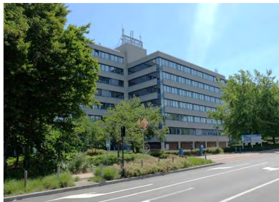
Figure 61 : Immeuble de bureaux à l'angle de la chaussée de Haecht et la rue du Planeur (ARIES, 2020)
