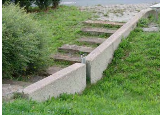
Noüe en pente avec « renforcement » au point bas (Quartier du Kronsberg, Hanovre – Valérie Mahaut)
