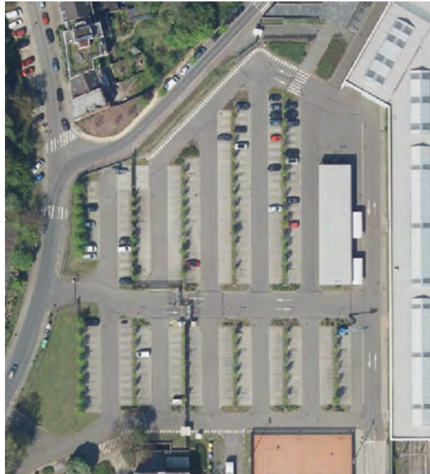
Figure 292 : Vue aérienne du parking (BruGIS, 2020)
