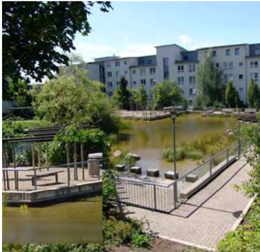
Bassin en eau de rétention (Quartier du Kronsberg, Hanovre – Valérie Mahaut)
