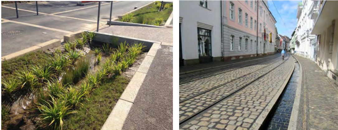
Figure 258 : Exemple de noue (Ecoquartier du Raquet) et de filet d'eau (Fribourg) en milieu urbanisé
