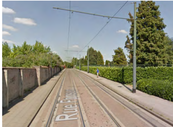
Figure 257 : Site propre tram existant rue Fonson (Google Street View, 2013)
