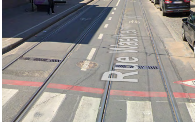
Figure 254 : Avaloirs au centre des voies de tram rue Waelhem (Google Street View, 2020)
