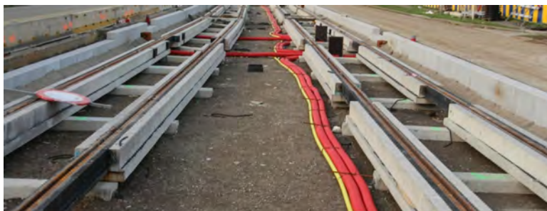
Figure 245: Installation type de voie poutres-rails (D2S, 2018)
