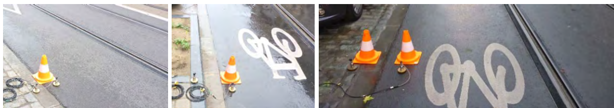
Figure 205 : Position capteurs sur et à côté de la dalle flottante en S1, S2 et S3 (D2S, 2018)
