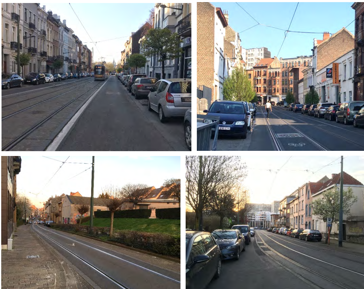
Figure 262 : Avenue de la Reine (en haut à gauche) ; Rue Waelhem (en haut à droite) ; Rue Van Hamme (en bas à gauche) ; Rue Fonson (en bas à droite) (ARIES, 2020)
