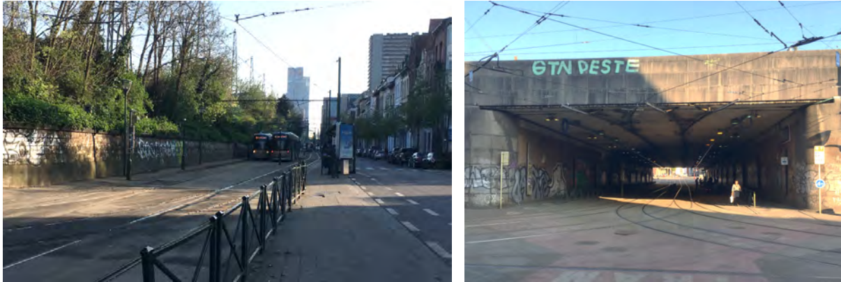
Figure 7 : Rue du Progrès (gauche) et tunnel Thomas (droite) (ARIES, 2020)
