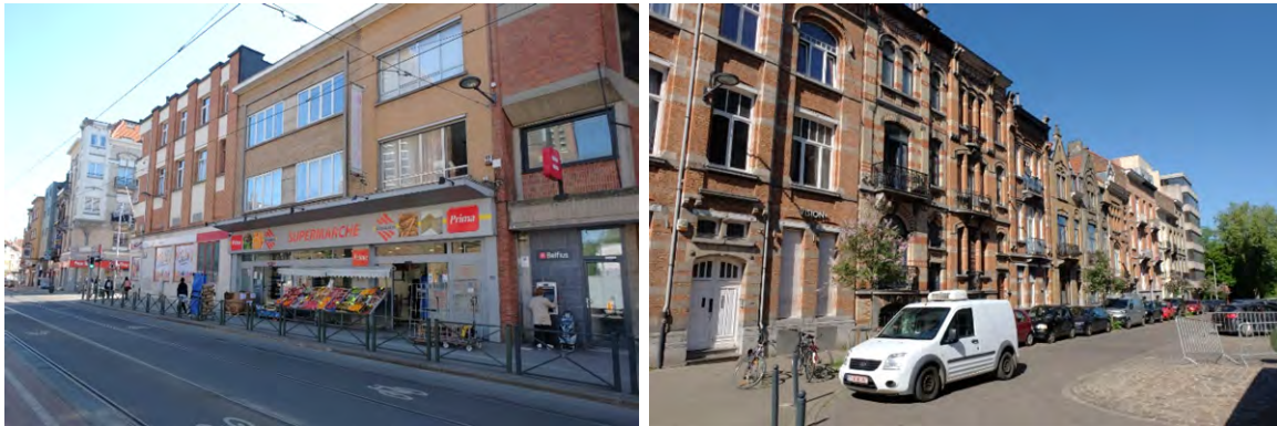
Figure 162 : Constructions sur la chaussée de Helmet (à gauche) et sur l'avenue Huart Hamoir (à droite) (ARIES, 2020)
