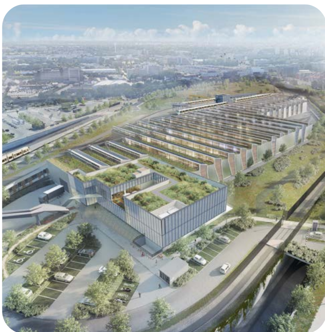
Le dépôt est entouré d'un mur anti-bruit végétalisé pour protéger les habitations
