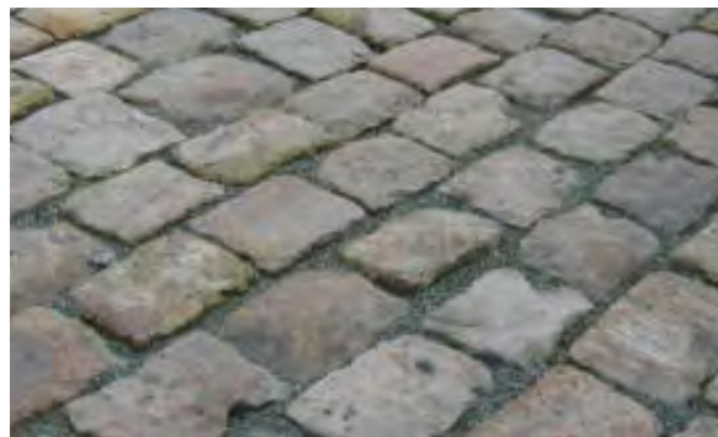
1. Pavé de récupération, zones de stationnement. Herstel kasseien, parkeerplaatsen.
