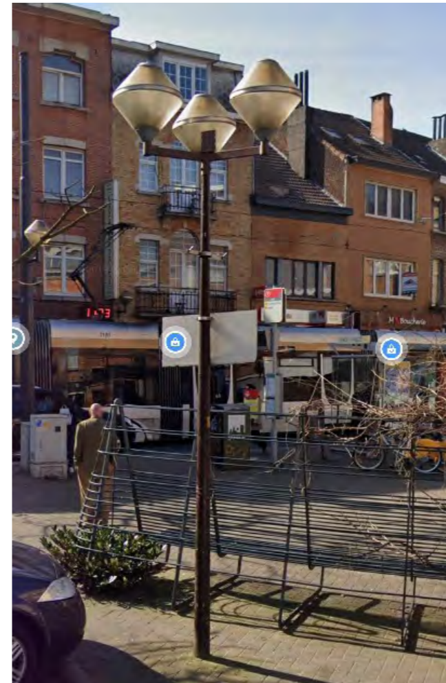
1. Mast - bestaande toestand Mât - situation existante
