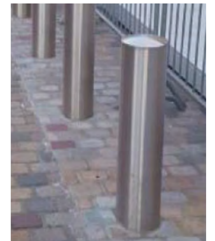
1. Borne anti-bélier en acier Inox anti-rampaal
