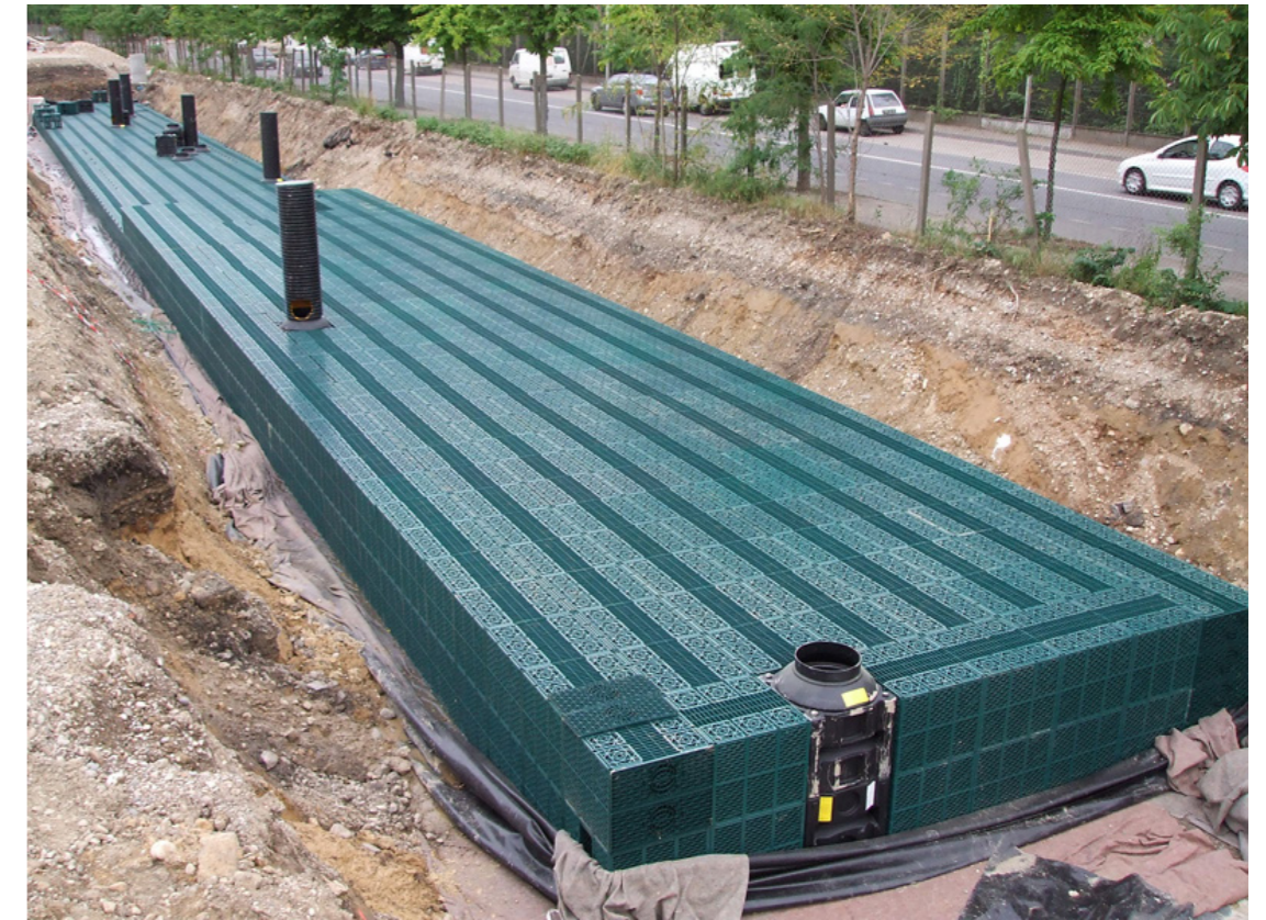
1. Infiltratiebekken - bassin infiltrant 65m 3
