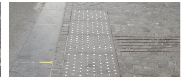
3. Plaatselijk verlaagde bordsteen bordure enterrée
