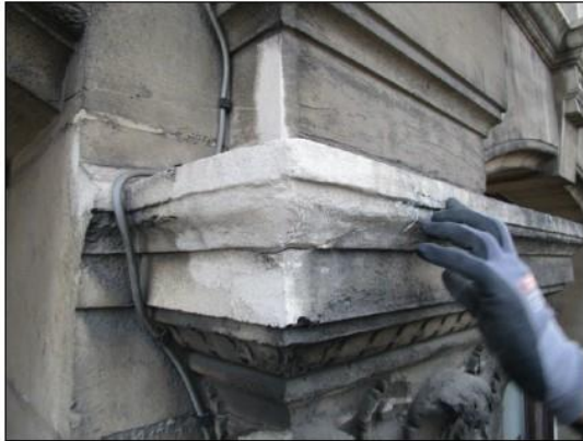
Situation avant enlèvement
