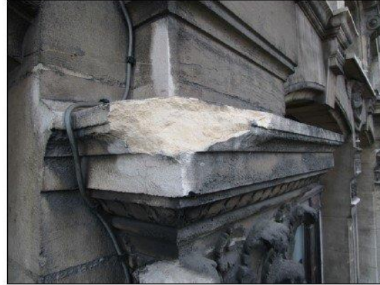
Situation après enlèvement
