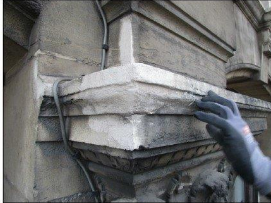
Situation avant enlèvement
